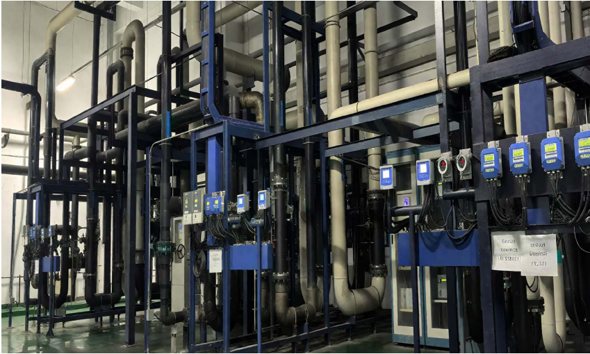
北京第 8.5 代 TFT-LCD 生产线通过使用再生水替代自来水进行超纯水的制备
