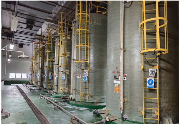
北京第 8.5 代 TFT-LCD 生产线废酸处置装置
